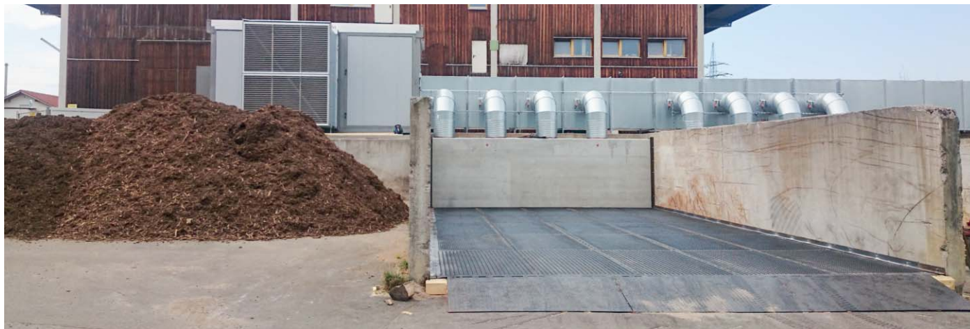
Aufbau der Unterkonstruktion bzw. Wände der Trocknungsboxen mit Holz, Beton oder Stahl möglich
