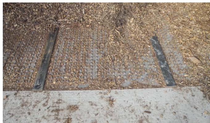
Ebene Einfahrt durch integrierten Belüftungsboden
